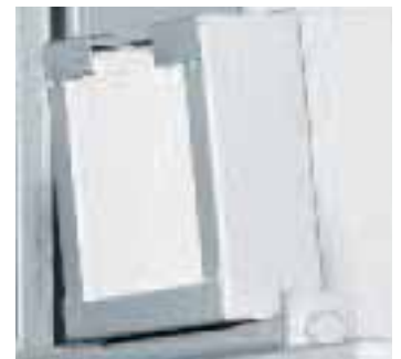
Automatic vapour vent flap
